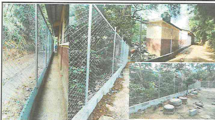
FOTO 2: MURO PERIMETRAL CON BASE Y DOS HILADAS DE BLOCK, REFORZADA CON TUBOS Y MALLA GALVANIZADA
