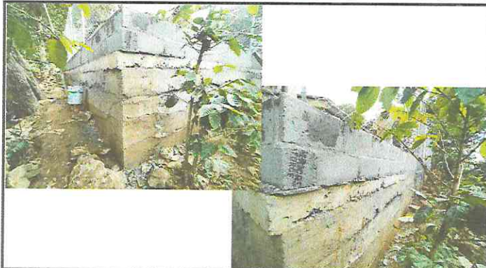
FOTO 1: MURO DE CONTENCIÓN CON CONCRETO CICLOPEO
