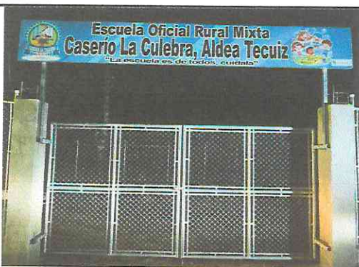
FOTO 5: SUMINISTRO DE PORTÓN DE MALLA GALVANIZADA
