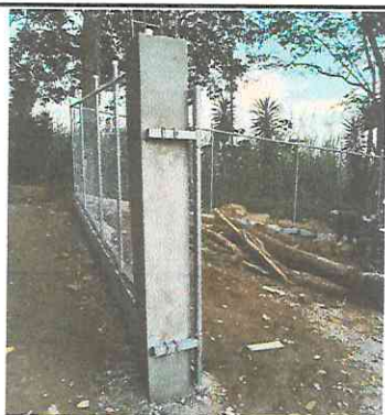
FOTO 3: COLUMNAS DE APOYO PARA PORTÓN
