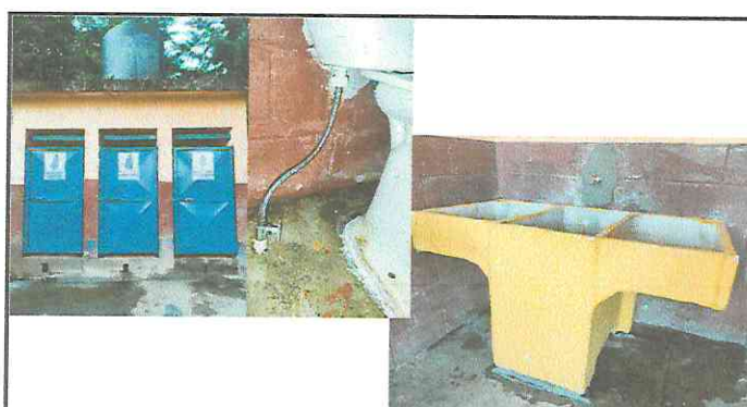
FOTO 6: SUSTITUCIÓN DE ACCESORIOS DE SANITARIOS Y SUSTITUCIÓN DE PILA DE CEMENTO DE DOS LAVADEROS
