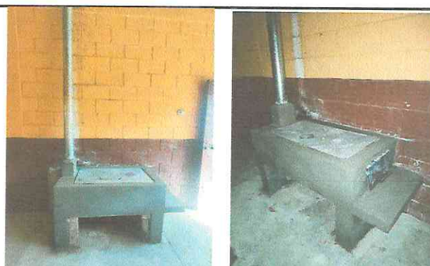
FOTO 4: SUSTITUCIÓN DE ESTUFA RURAL
